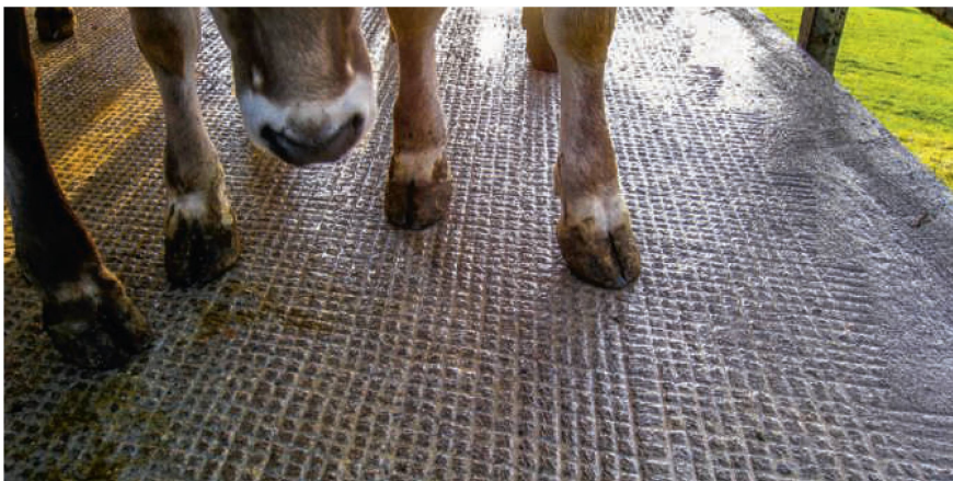
Die ganzflächige mechanische Sanierung soll die Rutschfestigkeit wiederherstellen. Für sicheres Laufen ist diese in Längs- und Querrichtung gleichermassen erforderlich, was beim Rillieren eine Bearbeitung in beide Richtungen voraussetzt.
