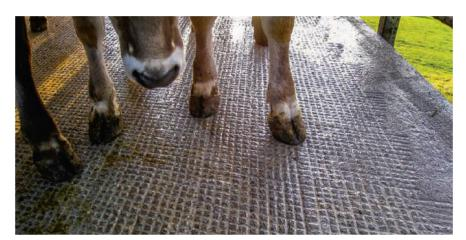
Die ganzflächige mechanische Sanierung soll die Rutschfestigkeit wiederherstellen. Für sicheres Laufen ist diese in Längs- und Querrichtung gleichermassen erforderlich, was beim Rillieren eine Bearbeitung in beide Richtungen voraussetzt.
