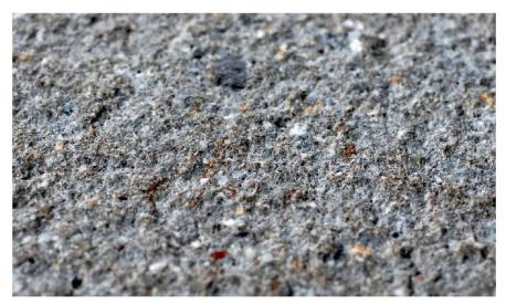
Sanierungsverfahren Hochdruck-Wasserstrahl mit Strahlmittel 0,6 bis 1 mm; erst durch komplettes Abtragen der Kalkschichten entsteht die erforderliche Rutschfestigkeit.
