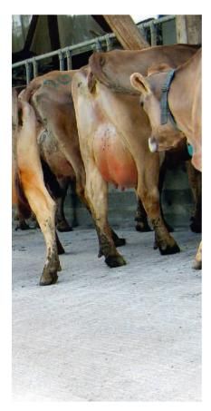
Sicheres Laufen setzt eine rutschhemmende Oberflächenstruktur voraus; das Sanierungsverfahren Rillieren-Aufrauen berücksichtigt Anforderungen der Tiere und der Verfahrenstechnik.
