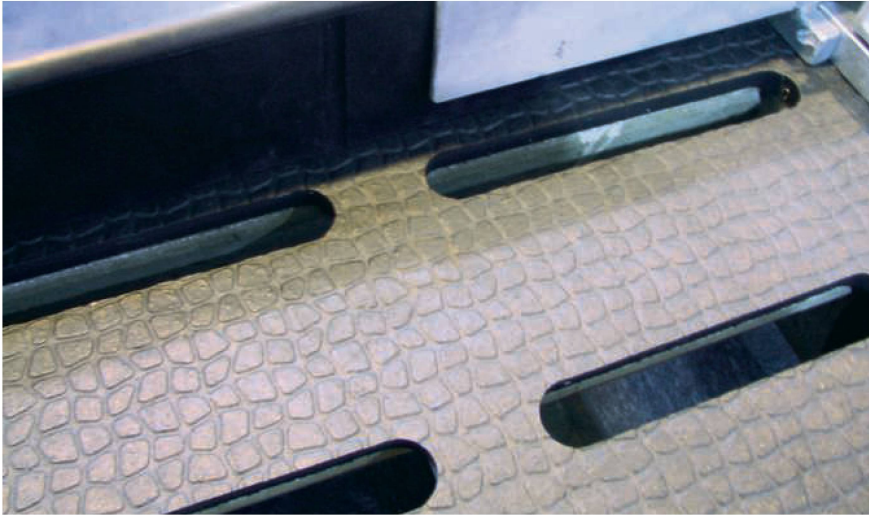
Die Perforation des elastischen Gummibelags muss genau auf den Spaltenboden abgestimmt sein. Anpassungen an der Entmistungstechnik sind unerlässlich.
