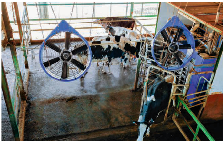
Die Unterstützungslüfter sollen mit einem Neigungswinkel von 12 bis 15 Grad montiert werden. Bild: DeLaval
