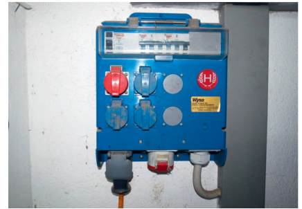
Mit Bauschaltkasten lässt sich eine einfache Stromverteilung samt FI-Schalter und Absicherung montieren.
