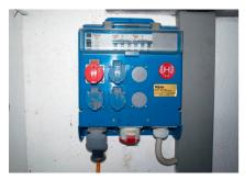
Mit Bauschaltkasten lässt sich eine einfache Stromverteilung samt FI-Schalter und Absicherung montieren.
