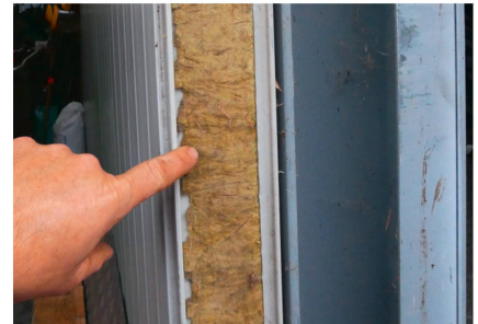
Sandwich-Paneele mit Steinwoll-Isolation für die Auskleidung einer Werkstatt sind feuerhemmend und pflegeleicht.
