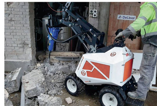
Die Hydraulikanlage mit starkem Kühler bietet für den Dauerbetrieb mit Hydraulikhammer genug Leistung.
