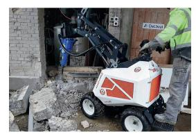
Die Hydraulikanlage mit starkem Kühler bietet für den Dauerbetrieb mit Hydraulikhammer genug Leistung.
