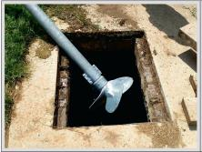
Holzabdeckungen sind immer problematisch. Sie können unter Einwirkung von dauernder Feuchtigkeit durch Fäulnis geschwächt sein. Oft sind Holzabdeckungen zu schwach wenn sie mit den heutigen Gewichten überfahren werden. Mit einem massiven, verzinkten Eisenrost der eine «Service-Öffnung» besitzt, könnte die Situation entschärft werden.
