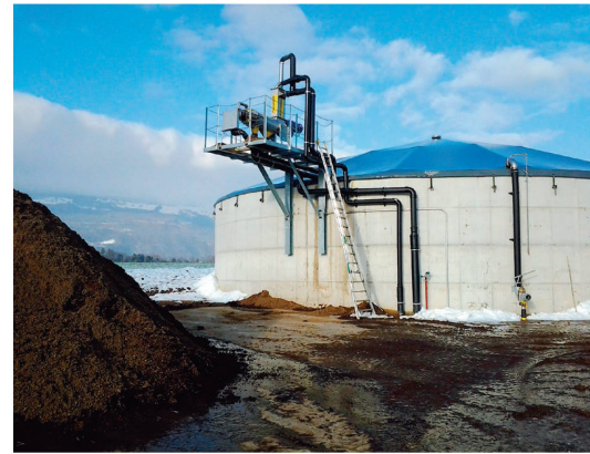
Separatoren mit Überlaufleitung werden bei Überflur-Behältern mit Vorteil auf einer erhöhten Plattform installiert. Bild: Fankhauser
