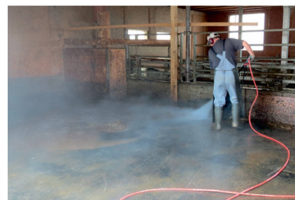
Bei genug Leistung ist es sogar möglich, mit dem Dreckfräser die Spaltenböden von Harnstein und Kalk zu befreien.
