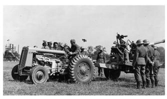
Das Zugfahrzeug Hürlimann «4 T 42» von 1932 ist mit einem 40 PS starken Petrolmotor Hürlimann «4 B 100» ausgestattet und hat ein 5-Gang-Getriebe, Differenzialsperre und Innenbackenbremsen auf den Hinterrädern.
