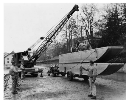
1935: Ein Michigan-Kran «50» mit einem Bührer «BD 4» vor einem Pontonanleger mit zwei Pontons Modell «1930/31»; das Ponton-Eigengewicht beträgt 550 kg, die Tragkraft 4500 kg bei 30 cm Freibord.
