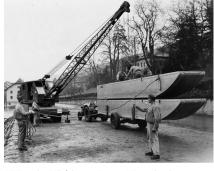
1935: Ein Michigan-Kran «50» mit einem Bührer «BD 4» vor einem Pontonanhänger mit zwei Pontons Modell «1930/31»: das Ponton-Eigengewicht beträgt 550 kg, die Tragkraft 4500 kg bei 30 cm Freibord.
