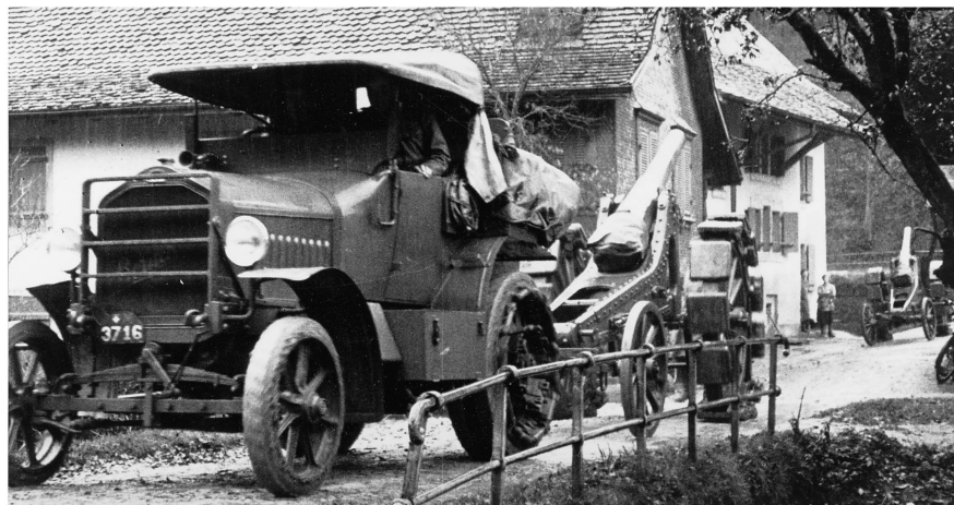
Je ein Berna-«T3»-Artillerie-Traktor von 1918 wurde den 19 bestehenden 12-cm-Kanonen-Batterien zugeteilt; sie brachten die von Lkw auf der befestigten Strasse herangebrachten Geschütze im Gelände in Stellung.
