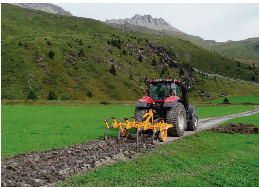
Vor dem Einsatz des Steinbrechers wird mit einem schweren Steingrubber die Naturstrasse auf die benötigte Tiefe aufgerissen.
