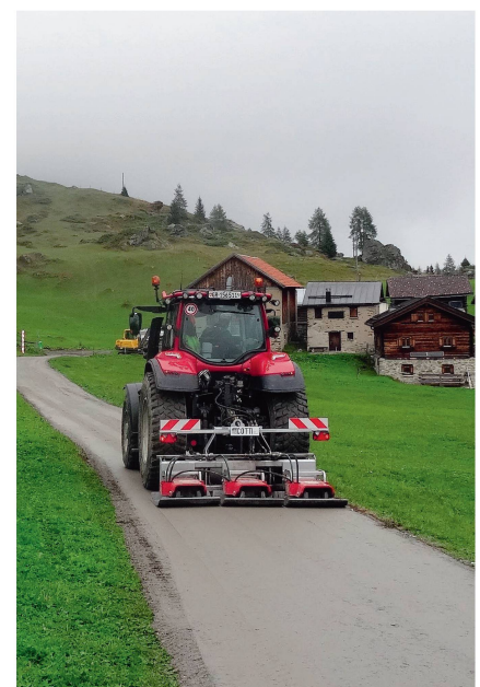
Zum Schluss kommt eine Dreifach-Rüttelplatte zum Einsatz.
