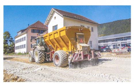
Die Zement-Kalk-Mischung wird vorgängig mit einem speziell für diesen Zweck geeigneten Streuer verteilt.
