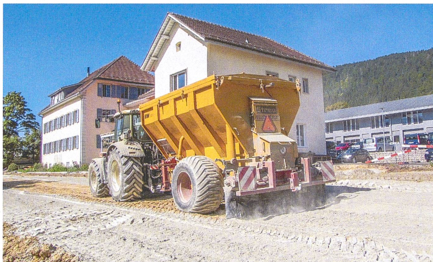
Die Zement-Kalk-Mischung wird vorgängig mit einem speziell für diesen Zweck geeigneten Streuer verteilt.
