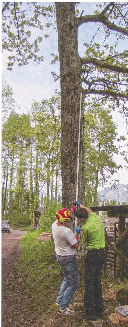
Mit einer Teleskopstange lässt sich das Seil schnell und sicher an einem instabilen Baum anbringen.
