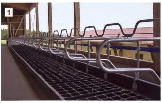
Die Wabenelemente aus Gummi werden genau ausgerichtet und mit je zwölf Schrauben fest mit dem Betonuntergrund verbunden.
