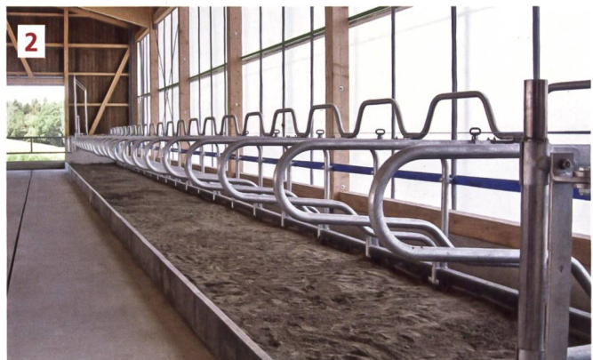
Der Sand wird auf eine Höhe von 3–5 cm über die Wabenkanten aufgefüllt und anschliessend fest verdichtet.
