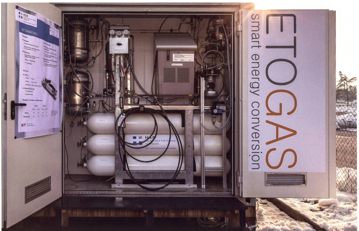
Das erzeugte Methangas wird mit Kompressoren verdichtet und in Gasflaschen bis zur Betankung gelagert.
