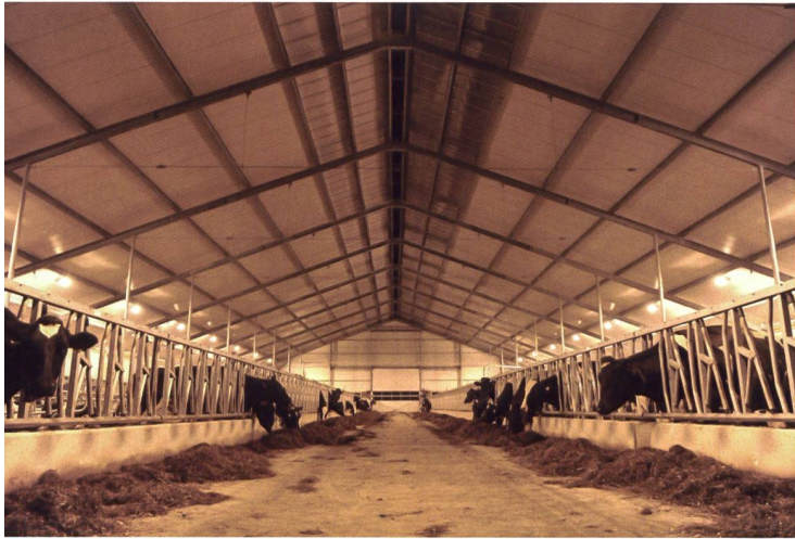
Die Stalllampen werden optimal gekühlt, sodass laut Hersteller eine Haltbarkeit von 30 Jahren erreicht wird. Ein Wärmeschutz dimmt die Leuchten automatisch, wenn die Temperatur zu hoch wird. Bild: Lely
