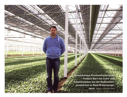
heiss. Schattierungsschirme müssen her, um die Hitzeenergie abzuhalten. Und genau das ist verschenkte Energie. Bart: «Anstelle solcher Schattierungsschirme setze ich Photovoltaikmodule ein, welche diese Energie in elektrischen Strom umwandeln.»
