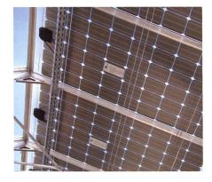
Oberes Bild: Die Glas-Glas-Solarmodule bilden das Dach. Das erfordert eine stärkere Tragkonstruktion.
