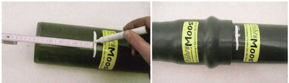
PVC-U-Rohre mit Steckmuffen können auch vom Landwirt selbst verlegt werden. Es ist sehr wichtig, den Steckbereich anzuzeichnen, damit jede Muffe bis zum Anschlag zusammensteckt ist.
