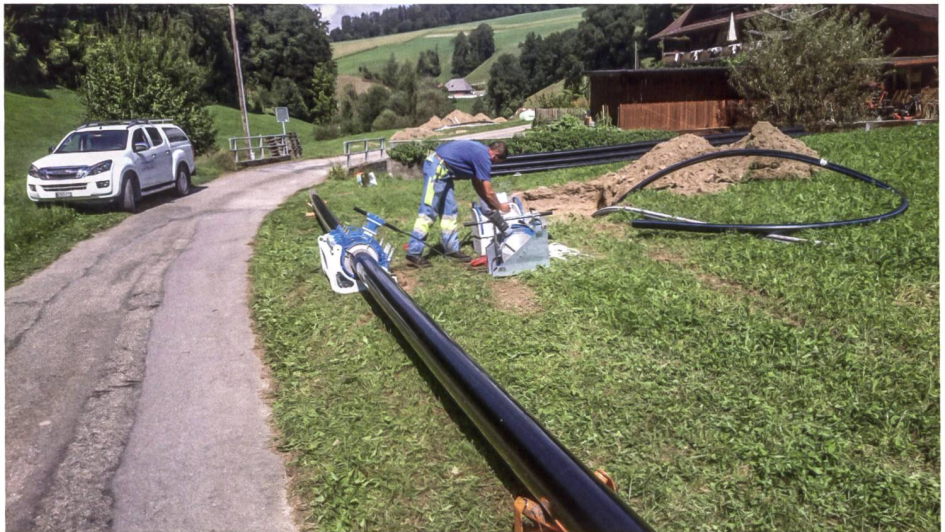
Das Zusammenschweissen von PE-Druckrohren erfordert eine Spezialausbildung und sollte deshalb dem Fachmann überlassen werden.
