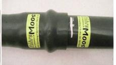
PVC-U-Rohre mit Steckmuffen können auch vom Landwirt selbst verlegt werden. Es ist sehr wichtig, den Steckbereich anzuzeichnen, damit jede Muffe bis zum Anschlag zusammengesteckt ist.
