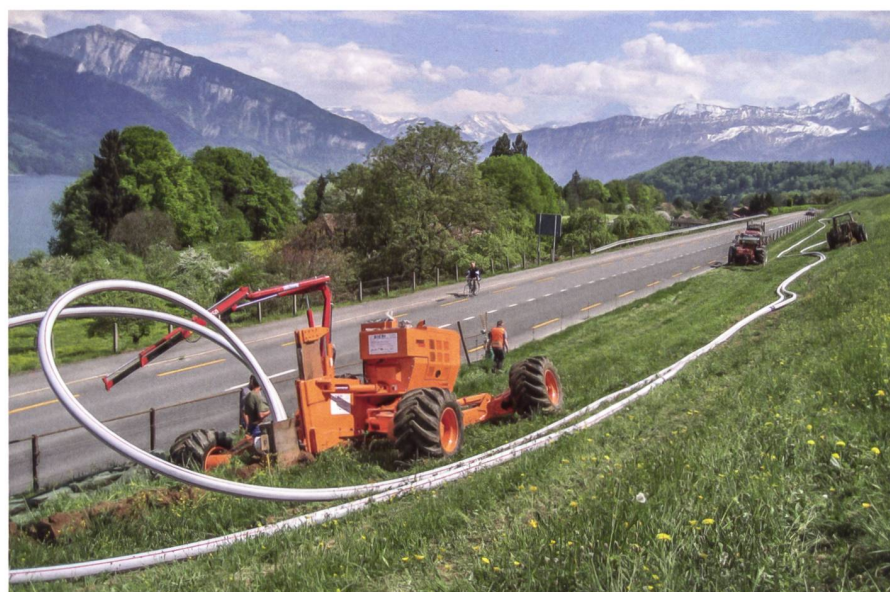
Beim Einpflügen können auch mehrere Leitungen in einem Durchgang in den Boden gebracht werden. Das Gefälle kann mit einer Lasersteuerung genau bestimmt werden.
