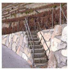
So sollte der Zugang zu einem Rebberg aussehen. Treppe mit korrekten Tritten und Geländer mit Handlauf.
