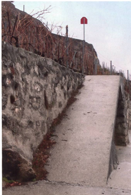
Betonrampe (Lavaux): Diese erlaubt den Zugang mit einem zu Fuss geführten Geräteträger. Breitere Konstruktionen können mit Geräten befahren werden, die über einen Fahrersitz verfügen.
