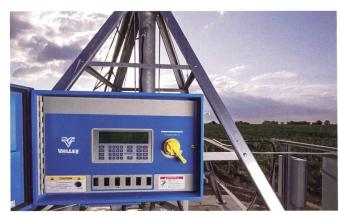
Der Zentralturm einer Kreis- oder Linearberegnungsanlage ist das «Hirn» der Anlage. Hier wird das Wasser eingespeist, und von diesem Punkt aus wird die Anlage gesteuert. Bild: Valley
