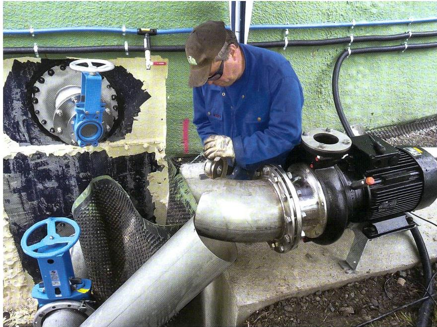
Der Gasmix wird extern installiert, was mehr Sicherheit und eine bessere Wartbarkeit bedeutet. Auch die Anlagekosten reduzieren sich, da keine Bedienungsstege, Plattformen oder Kransysteme mehr notwendig sind und die Anschaffungskosten dafür entfallen. Quelle: Landia GmbH.
