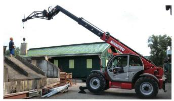
Schieber mit Seilwinde wunschgemäss platzieren
