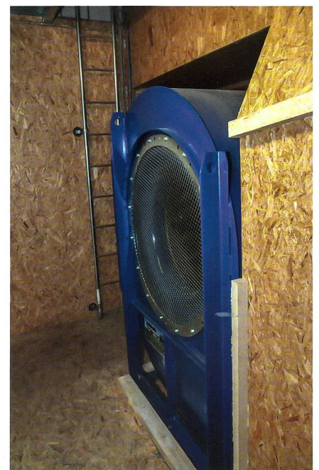
Der speziell druckstabile Ventilator benötigt eine elektrische Leistung von maximal 22 kW.
