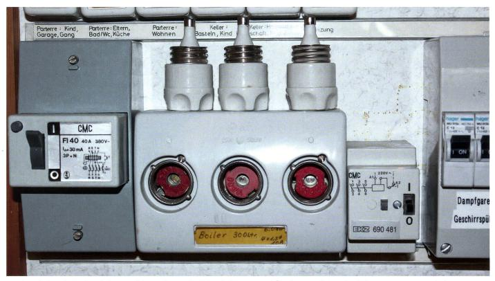
Das Ausschalten des Boilerschalters und das Entfernen der Schmelzsicherungen (oder das Ausschalten des Sicherungsautomaten) sind die ersten Massnahmen beim Entkalken des Boilers. Sie dienen dem Personenschutz und verhindern, dass bei der Fernschaltung durch das Elektrizitätswerk der Boileranschluss ungewollt unter Spannung steht. (Bilder: Ruedi Gnädinger)
