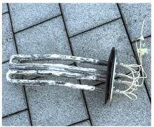
Entkalktes Heizregister: Eine «blitzblanke» Entkalkung etwa durch chemische Mittel ist nicht nötig. Bei der mechanischen Entkalkung mit einem Spachtel dürfen die einzelnen Heizstäbe nicht beschädigt werden.
