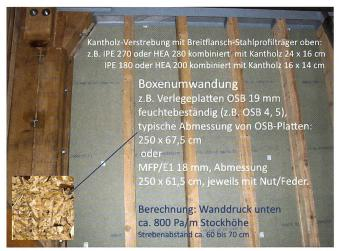
Abb. 4: Ausführung einer Boxenwand.
