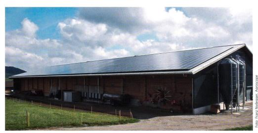
Heubelüftungsanlage mit Fotovoltaikpanels: Die elektrische und thermische Nutzung der Sonnenenergie erlaubt eine klimaschonende Heutrocknung.
