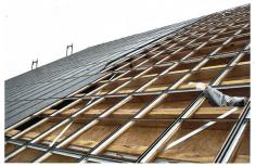
Abb. 13: Dachabsaugung kombiniert mit Fotovoltaik.
