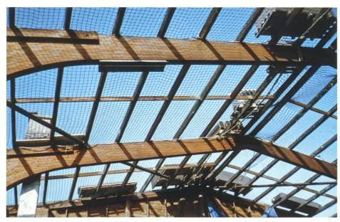
Damit keine Personen durch die Dachfläche hindurchbrechen und abstürzen können, müssen zusätzliche Auffangnetze unterhalb der Dachfläche montiert werden. (Bild: BUL)
