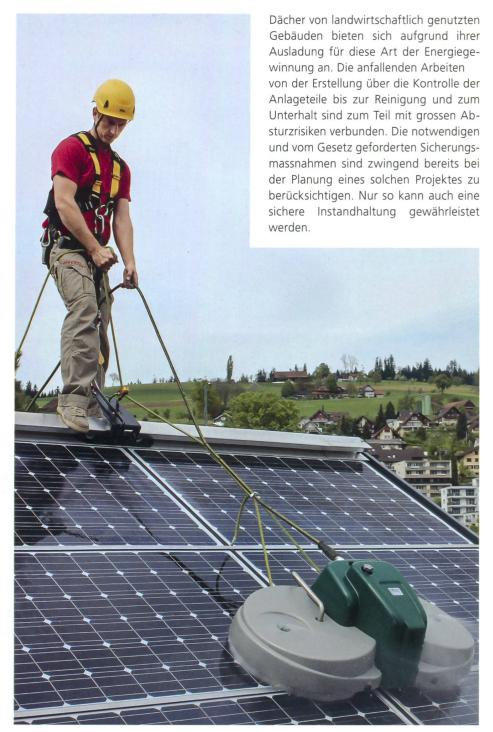
Mit dem System «Firstkönig» ist ein permanenter Absturzschutz schon beim Aufstieg gewährleistet. (Bilder: zVg)
