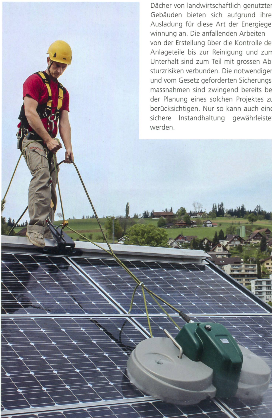
Mit dem System «Firstkönig» ist ein permanenter Absturzschutz schon beim Aufstieg gewährleistet. (Bilder: zVg)
