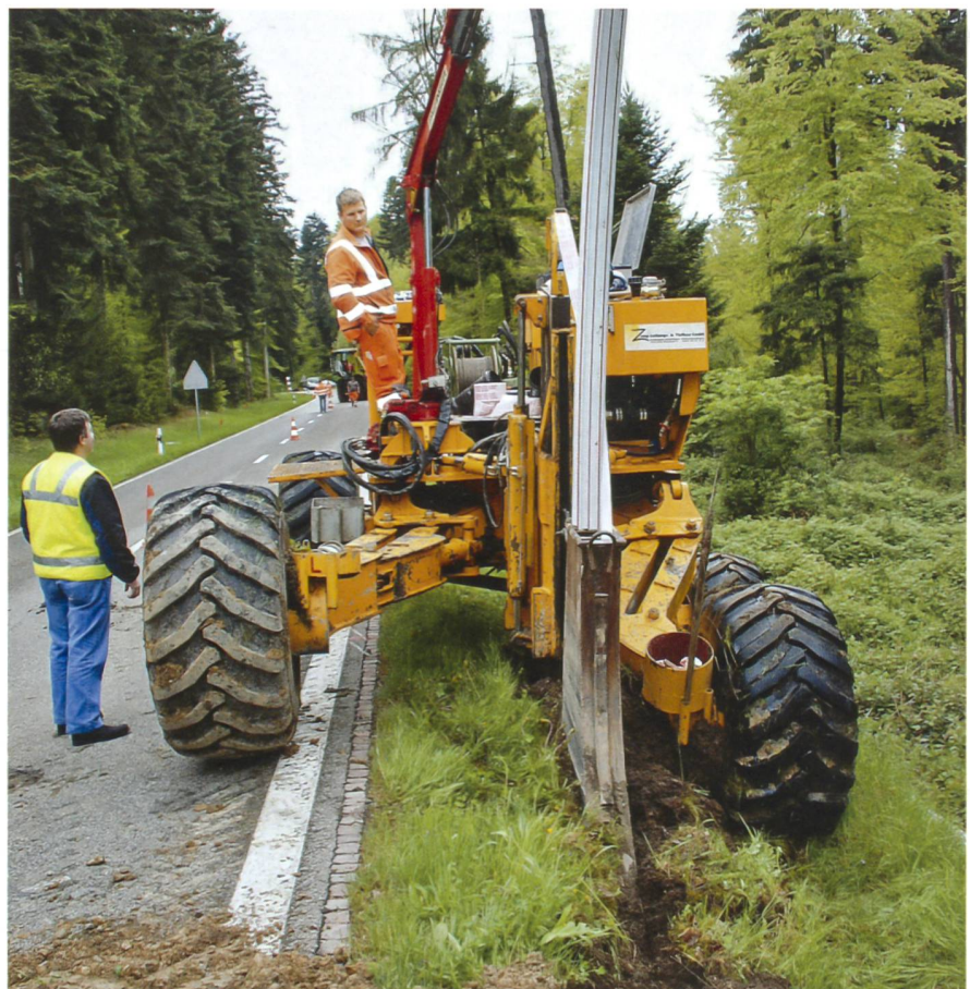
Rohr und Warnband sind in den Kanal hinter dem Pflugmesser am Menzi-Muck eingelegt, das Einpflügen in die Strassenböschung beginnt. (Bilder: Dominik Senn)
