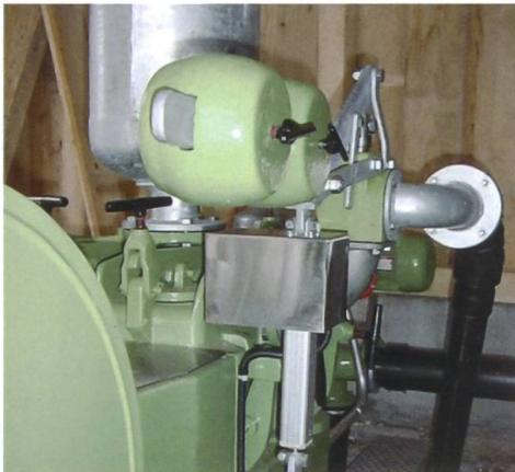
Die Pumpen der Meier AG können auf Wunsch mit einem elektronischen Überdruckventil ausgestattet werden. In Verbindung mit einer Frequenzsteuerung lässt sich so der Druck automatisch auf ein Maximum begrenzen. ([www.meierag.ch](http://www.meierag.ch))
