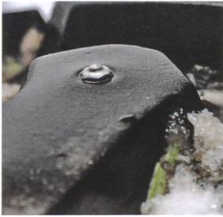
Korrekt montiert steht der Stift etwa 3 mm über den Gummi hinaus.
