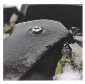
Korrekt montiert steht der Stift etwa 3 mm über den Gummi hinaus.
