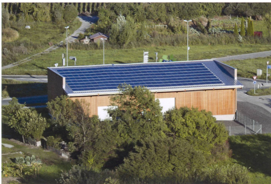
Die im September 2012 in Betrieb genommene Solaranlage auf dem Ökonomiegebäude des Weinguts Cave du Rhodan in Salgesch ist Bestandteil des Projekts EEE und produziert rund 50 000 kWh Strom pro Jahr.
