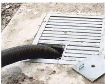
Ist der Einbau eines festen Entnahmestutzens nicht möglich, muss eine kleine Entnahmeöffnung vorhanden sein. Der Deckel ist gegen Verlust zu sichern.
