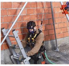
Mit einem Frischluftgerät kann auch ohne Durchlüftung in eine Grube eingestiegen werden. Auskunft: landw. Bildungszentren, Feuerwehr, BUL/agriss.
