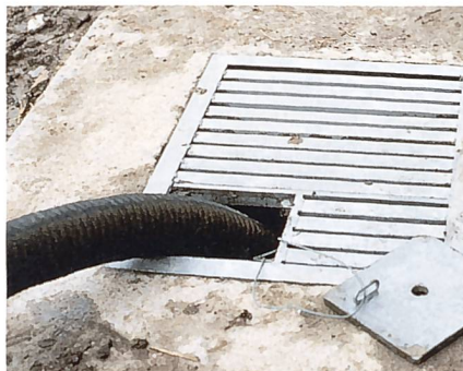
Ist der Einbau eines festen Entnahmestutzens nicht möglich, muss eine kleine Entnahmeöffnung vorhanden sein. Der Deckel ist gegen Verlust zu sichern.
