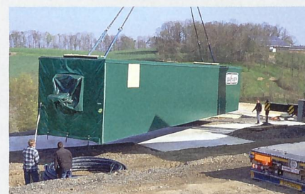
Die mobile Biogasanlage «GülleWerk» der Firma AgriKomp wird installiert.
