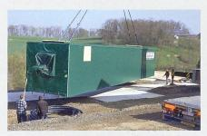
Die mobile Biogasanlage «GülleWerk» der Firma AgriKomp wird installiert.
