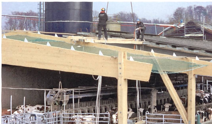
Die Stallerweiterung benötigt viel Holz, wie die Bauarbeiten zeigen.
