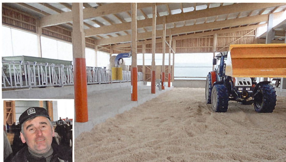
Auf dem Betrieb von Franz Zeilinger kann die Lüftung mit Rollvorhängen gesteuert werden. Oben im Dach ist eine grosse Lüftungsöffnung vorhanden.
