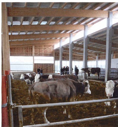
Auf dem Betrieb von Franz Zeilinger kann die Lüftung mit Rollvorhängen gesteuert werden. Oben im Dach ist eine grosse Lüftungsöffnung vorhanden.
