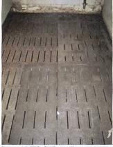
Betonrost mit 8% Perforationsanteil (Hersteller: Schmidiger Betonelemente AG)
