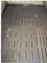
Betonrost mit 6% Perforationsanteil (Hersteller: Schmidiger Betonelemente AG)
