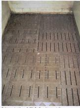
Betonrost mit ca. 6,4% Perforationsanteil («Optifloor» der Firma Hölschner + Leuschner in D)
