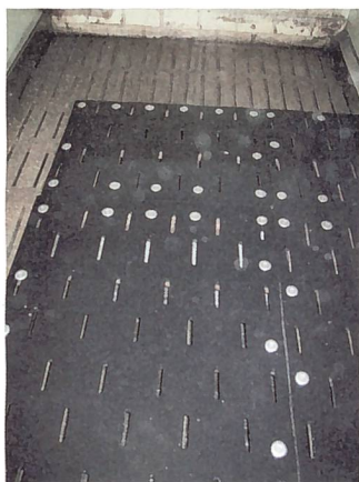
Gummimatte mit 5% Perforationsanteil (Hersteller: Kraiburg Elastik GmbH, D)
