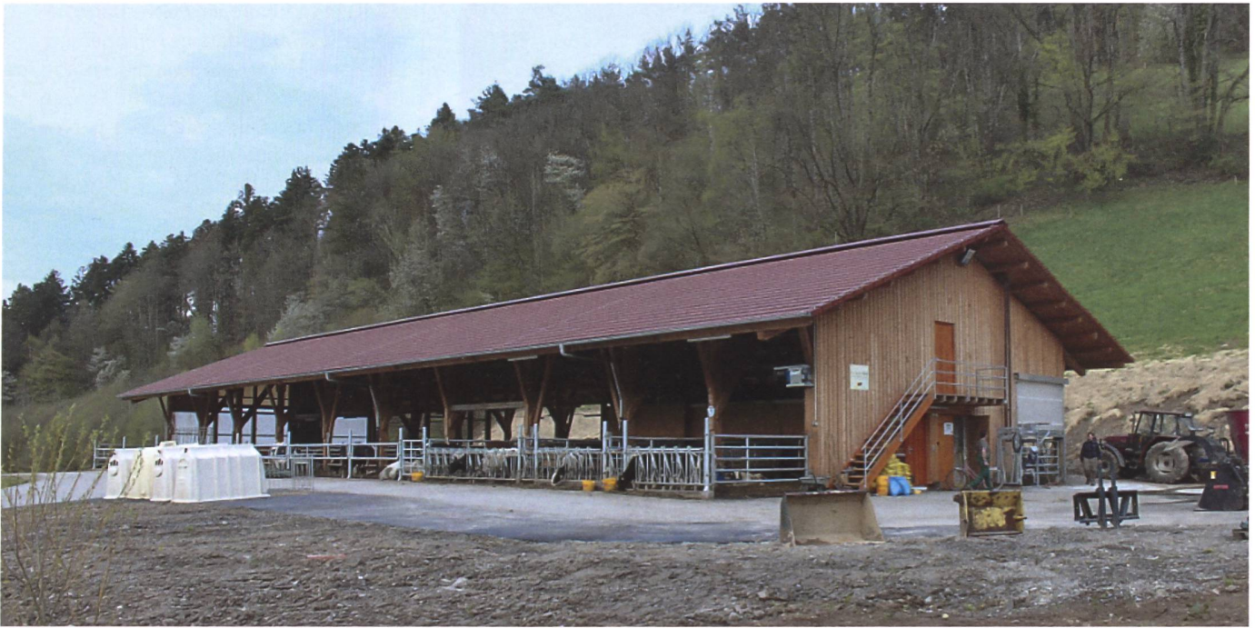
Gesamtansicht des Boxenlaufstalls mit dem teilweise überdeckten Laufhof. Dieser wird wie die übrigen Flächen mit einem Schieber entmistet.
