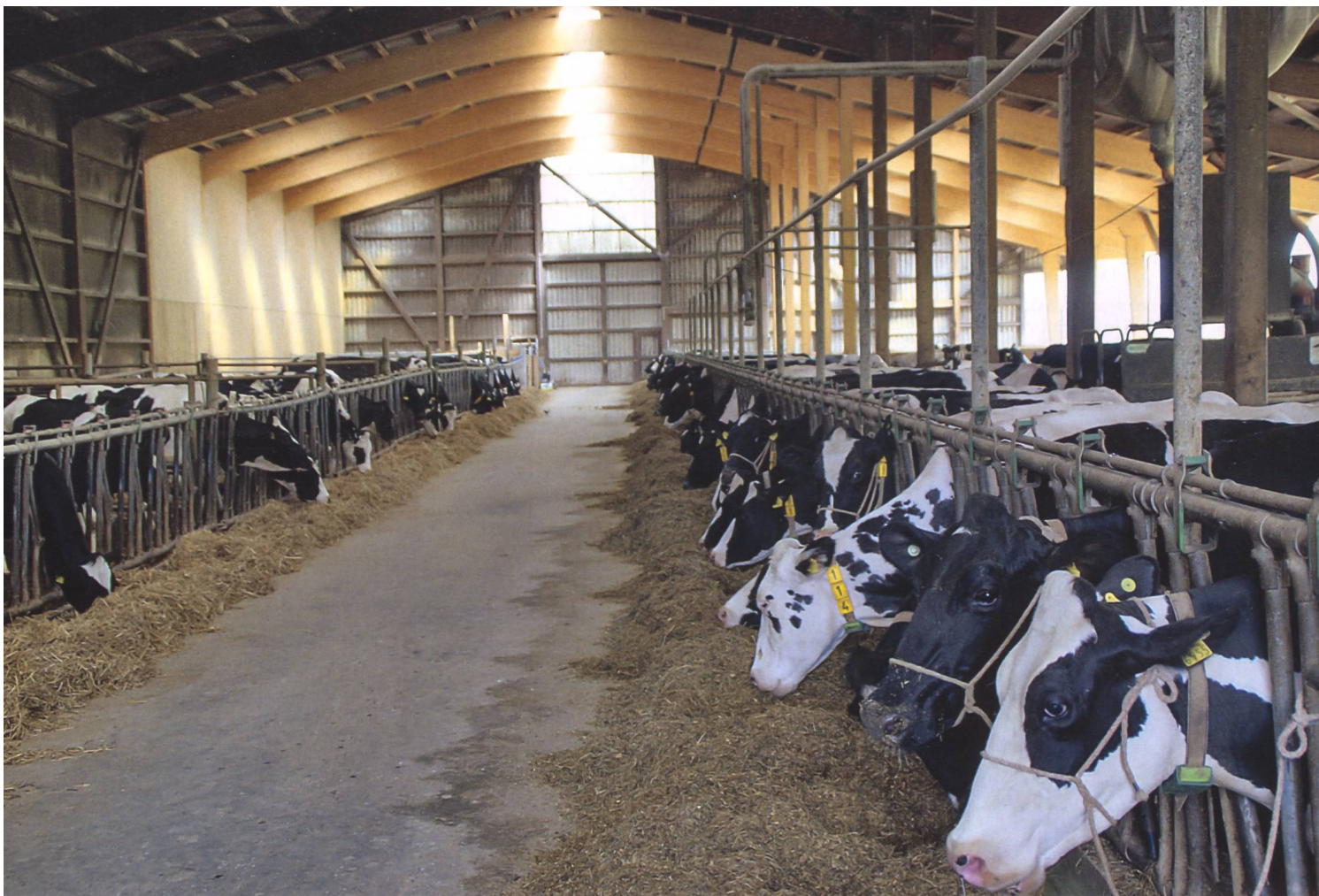
Im neuen Stallteil (hinten) ist die Firstöffnung breiter. Es ist heller, die Abluft entweicht besser und das Holz bleibt trockener. Von Vorteil für den Luftaustausch wäre ein Spaceboard oder ein Curtain anstatt einer geschlossenen Wand. (Bilder: Michael Götz)
