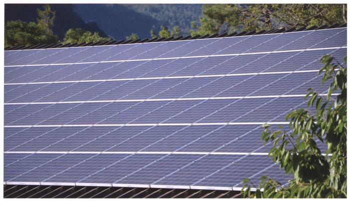
Wenn die Sonnenbestrahlung aller Module gleichmässig ist, kann ein einziger Wechselrichter eingesetzt werden. Bei unterschiedlicher Dachneigung empfiehlt es sich, für die jeweiligen Modulflächen separate Wechselrichter zu nutzen. (Bilder: Ruedi Hunger)
