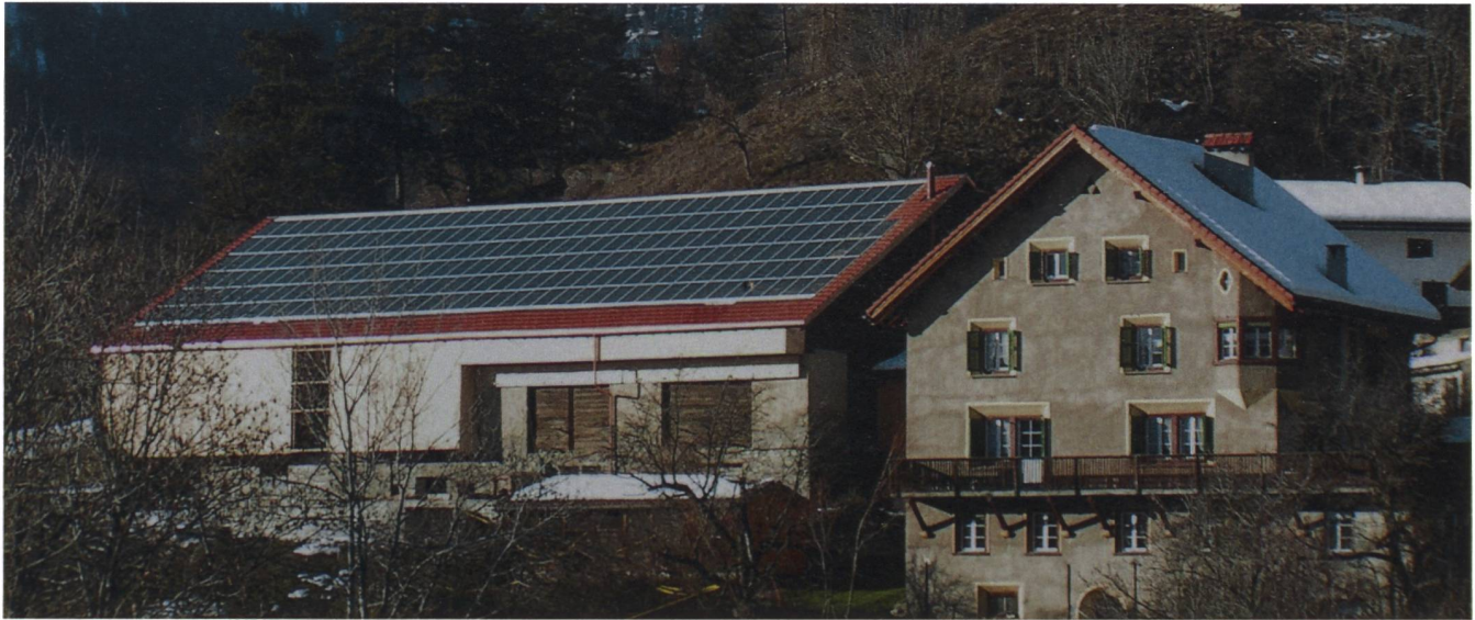
Eine ins Dach integrierte Fotovoltaikanlage zur Produktion von elektrischer Energie und mit thermischer Nutzung als Sonnenkollektor für die Heubelüftung.
