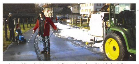
... gleich anschliessendes Auftauen von Eisflächen mittels aufgesprühter Sole; der «IceFighter» von Eco Technologies ermöglicht eine Einsparung von gegen 75 Prozent Streusalz gegenüber der herkömmlichen Methode. (Bilder: Dominik Senn)
