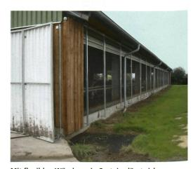
Mit flexiblen Wänden wie Curtains lässt sich das Stallklima mittels Quer- und Schwerkraftlüftung sehr gut regulieren. Sie sind auch weniger anfällig auf Hagelschäden. Allerdings halten sie sehr hohen Windgeschwindigkeiten nicht stand.
