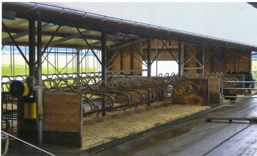
Besonders die offene Leichtbauweise mit grossen Spannweiten kann bei Extremereignissen zu Grenzbelastungen der Baustatik führen. (Bilder: Christian Guler)
