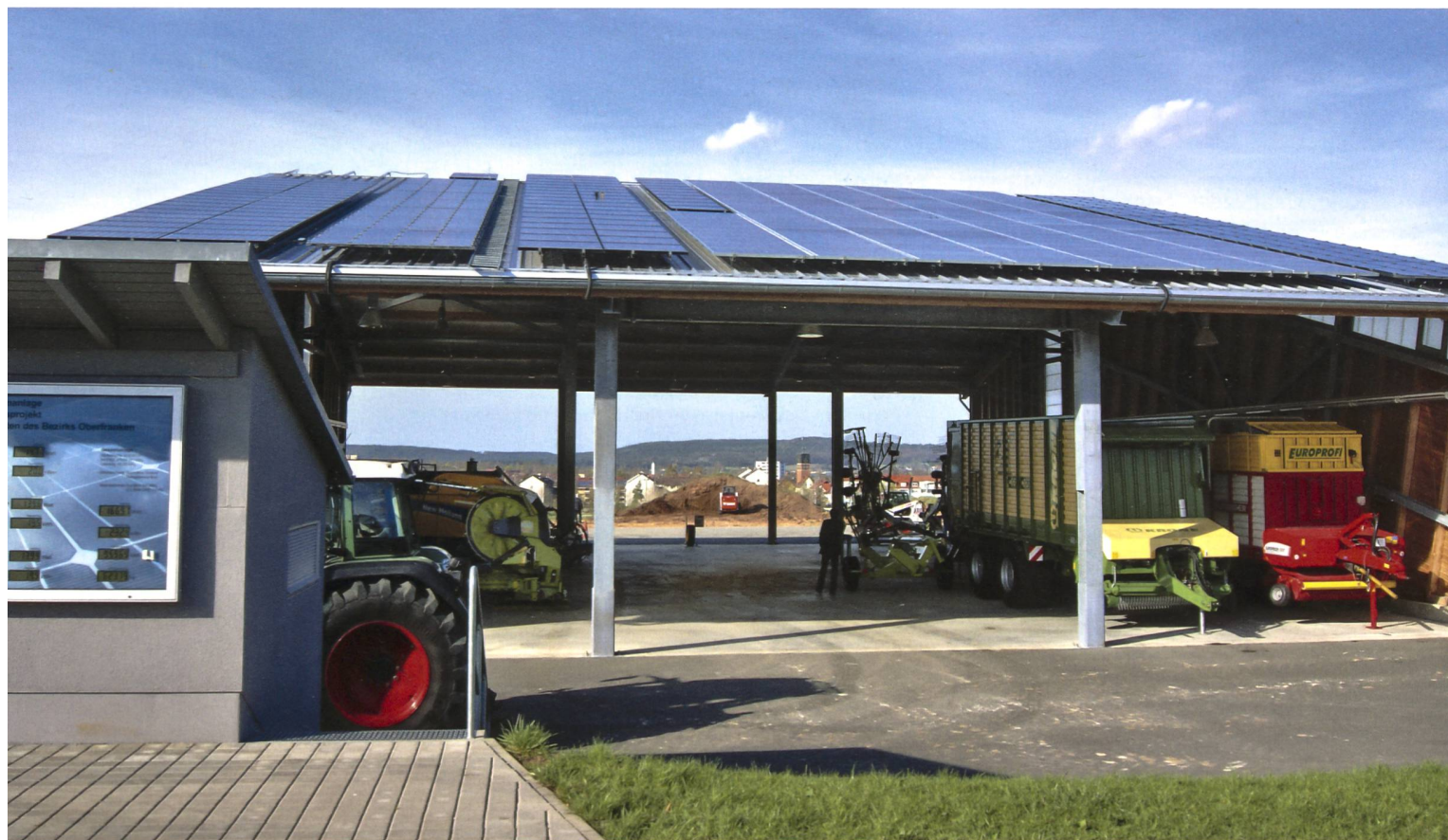
Photovoltaikanlage zu Demonstrationszwecken auf dem Schulgutsbetrieb der landwirtschaftlichen Lehranstalten für Oberfranken in Bayreuth. Die verschiedenen Modultypen heben sich deutlich voneinander ab und links im Bild sieht man die digitale Anzeige mit den momentanen und summierten Leistungsdaten. Bild: Ueli Zweifel
