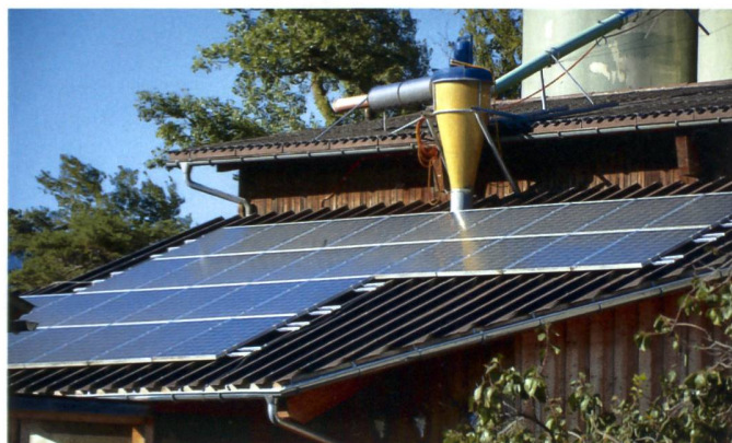
Dank guter Unterlüftung werden Solarmodule nicht zu stark erhitzt und ein guter Wirkungsgrad bleibt erhalten.
