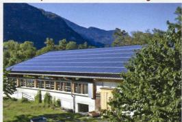
Bei einem Neubau können Ausrichtung und Dachneigung optimal gewählt werden. Bilder: Ruedi Hunger
