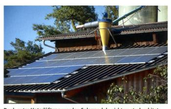
Dank guter Unterlüftung werden Solarmodule nicht zu stark erhitzt und ein guter Wirkungsgrad bleibt erhalten.
