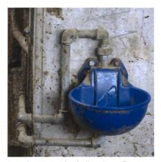
Je mehr Wasser durch die Leitung fliesst, desto weniger besteht die Gefahr, dass Wasser in Tränkerohren einfriert. Tränken sollten deswegen am selben Leitungsstrang hintereinander geschaltet werden.
