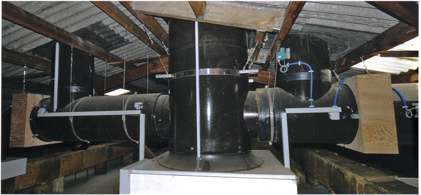
Die Wärmerückgewinnungsanlage im Dachstock beheizter Schweine- und Geflügelställe spart viel Energie und steuert die Lüftung erst noch besser. (Bild: ART)
