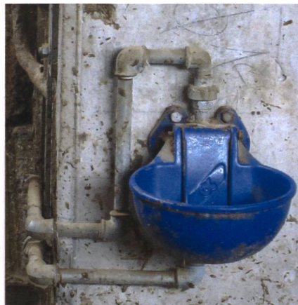
Je mehr Wasser durch die Leitung fliesst, desto weniger besteht die Gefahr, dass Wasser in Tränkerohren einfriert. Tränken sollten deswegen am selben Leitungsstrang hintereinander geschaltet werden.
