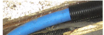
Bei «Sanipex»-Rohren gibt es einen wärmedämmenden Luftspalt zwischen wasserführendem Innenrohr und Mantelrohr.
