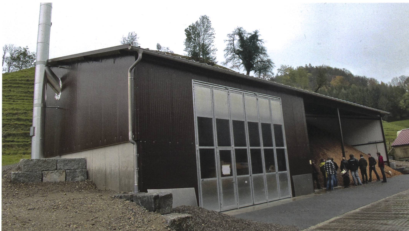
Blick auf das Schnitzellager und in die Heizzentrale (Bild rechts) des Biohofs von Ursula und Martin Lüssi in Turbenthal ZH. Die Leistung des Schnitzelkessels beträgt 530 kW. Die 2010 in Betrieb genommene Anlage beheizt zurzeit zwei Gewerbebetriebe sowie mehrere Ein- und Mehrfamilienhäuser in der Nachbarschaft. Das Wärmenetz wird laufend erweitert. (Bilder: Andreas Keel)
