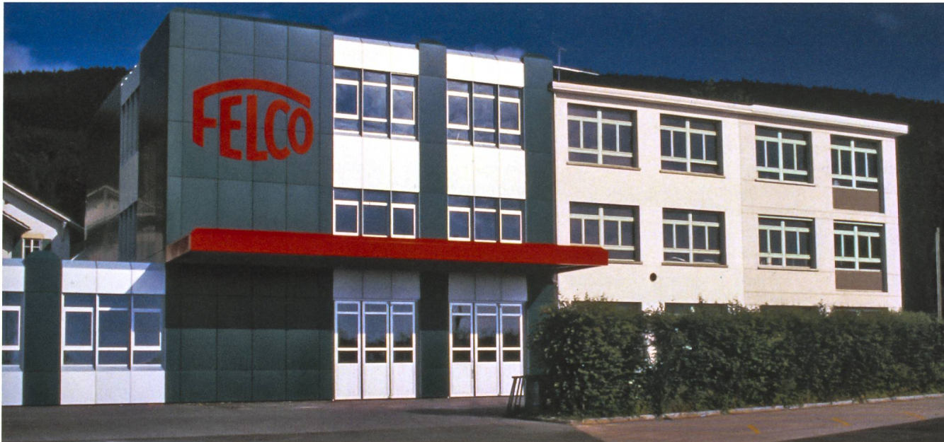
Felco-Produktionsstandort in Les Geneveys-sur-Coffrane/NE. Die Felco Motion ist in einem Neubau in der Industriezone des Dorfes.
