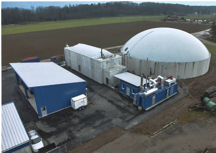
Im liegenden Fermenter mit Nassvergärung (Bildmitte) werden jährlich 7000 t organische Abfälle und 1800 t Grünabfälle und Gülle bei 55° C vergärt. Rechts der Nachgär- und Lagerbehälter. (Bild: zVg)
