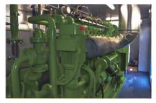
Der Gasmotor mit einen Wirkungsgrad von 38% hat eine Leistung von 330 kW. (Bild: Paul Müri)
