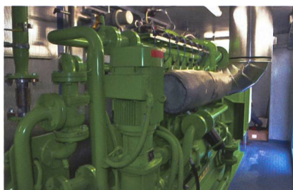
Der Gasmotor mit einen Wirkungsgrad von 38% hat eine Leistung von 330 kW. (Bild: Paul Müri)
