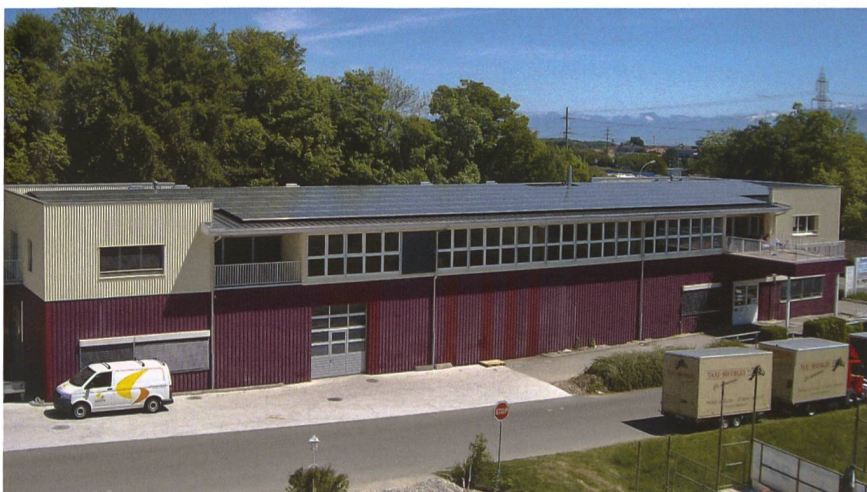
Auf diesem Lagerhaus für Düngemittel konnten dank geringer Neigung beide Dachflächen mit Solarpanels bestückt werden.
