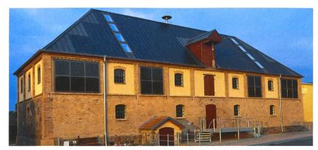
Kornspeicher in Brandenburg mit integrierten PV-Dünnschichtzellen auf dem Dach und kristallinen Modulen an der Fassade.
