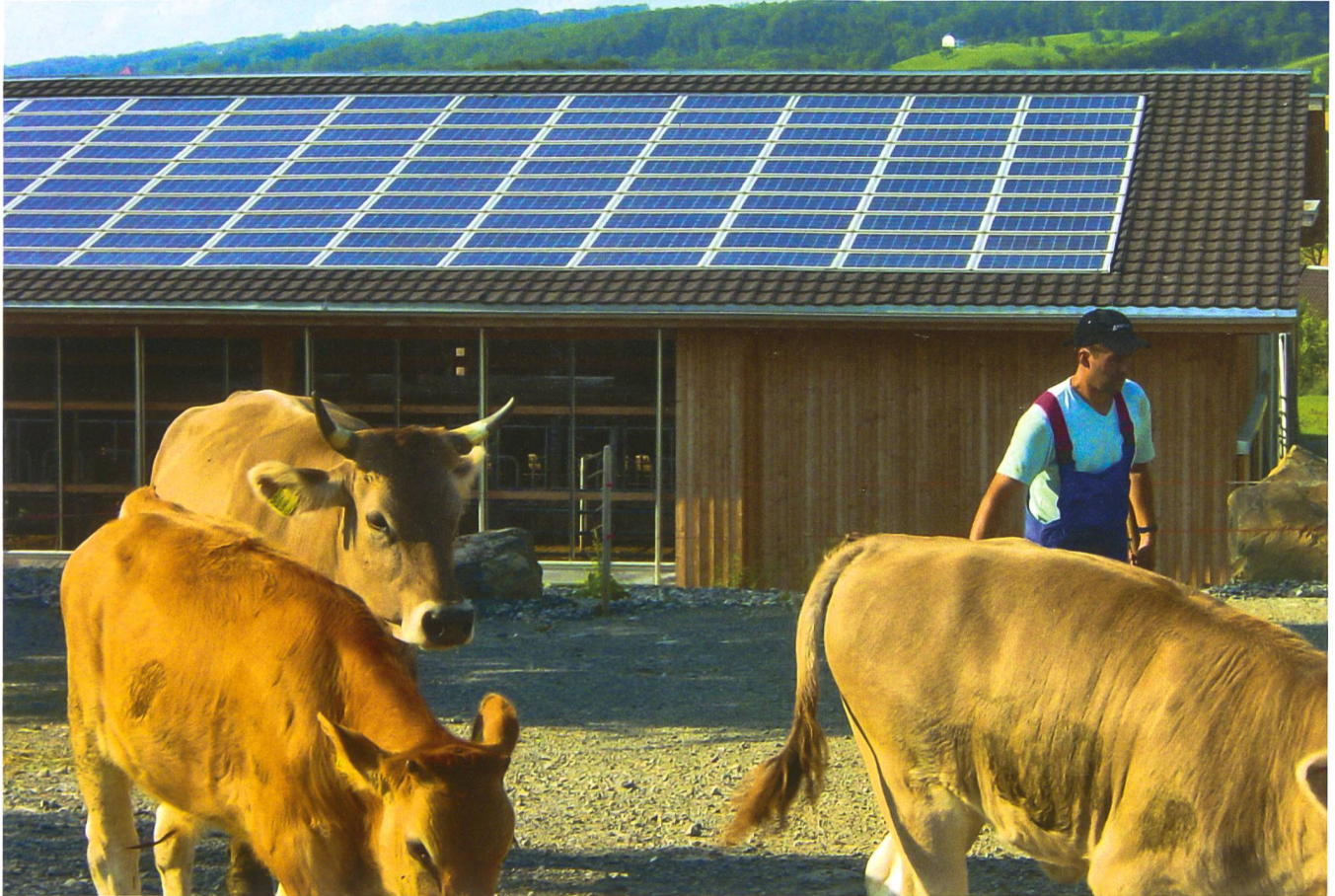
20 bis 30 Grad Neigung in südlicher Exposition sichert den besten Stromertrag. Die Faustregel lautet: 7 Quadratmeter Fläche für ein Kilowatt Spitzenleistung. Die damit produzierbare Energie wird im Mittel auf 930 kWh pro Jahr geschätzt. Anlage auf dem Süddach des Stalls beim Kloster Baldegg LU. (Bilder: SWISSOLAR)
