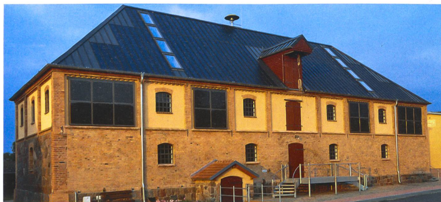
Kornspeicher in Brandenburg mit integrierten PV-Dünnschichtzellen auf dem Dach und kristallinen Modulen an der Fassade.
