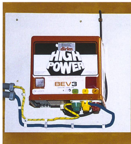
Netzgeräte müssen auf einer nicht brennbaren Unterlage montiert und korrekt geerdet sein.
