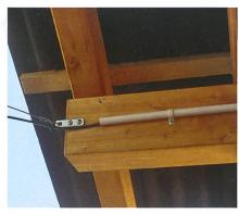
Entlang von Gebäuden müssen Zaunzuleitungen mittels Hochspannungskabeln in schwerentflammbaren Rohren verlegt sein.
