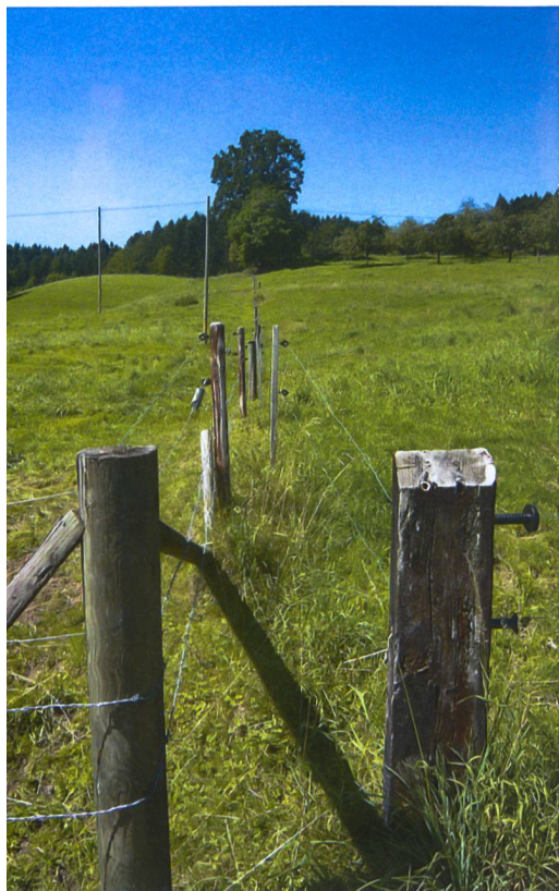
Diese Situation kann gefährlich werden. Unabhängige Zäune dürfen nur von verschiedenen Zaungeräten gespeist werden, wenn sie einen Abstand von mehr als 2 m haben. (Bilder: BUL)
