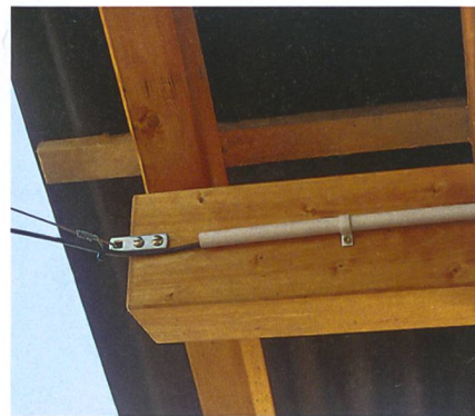
Entlang von Gebäuden müssen Zaunzuleitungen mittels Hochspannungskabeln in schwerentflammenden Rohren verlegt sein.
