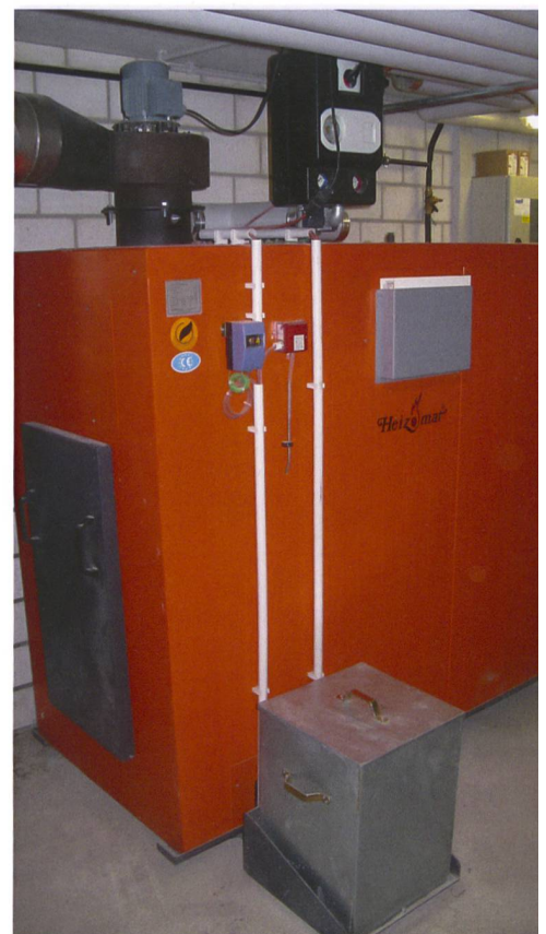
Die Verbrennung von Stroh und Chinaschilf bedingt das Anpassen der Verbrennungsregelung und korrosionsfeste Feuerungen.
