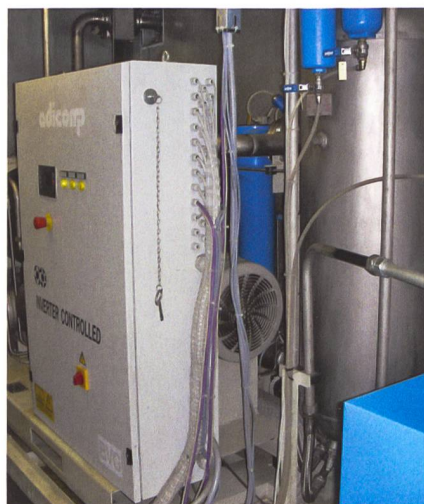
Anlage mit Minigebläsen zur Nutzung von Biogas.
