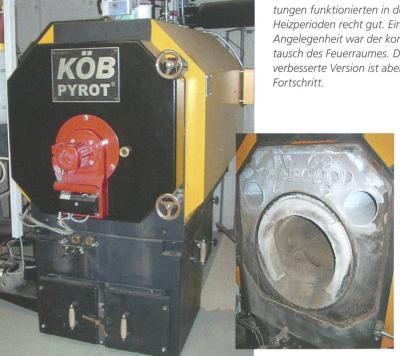
Der Kessel wird je Heizperiode durchschnittlich vier Mal entrusst. Dank einem leistungsfähigen Industriesauger mit vorgeschaltetem Russabscheider ist dies ohne grosse Staubentwicklung möglich.
